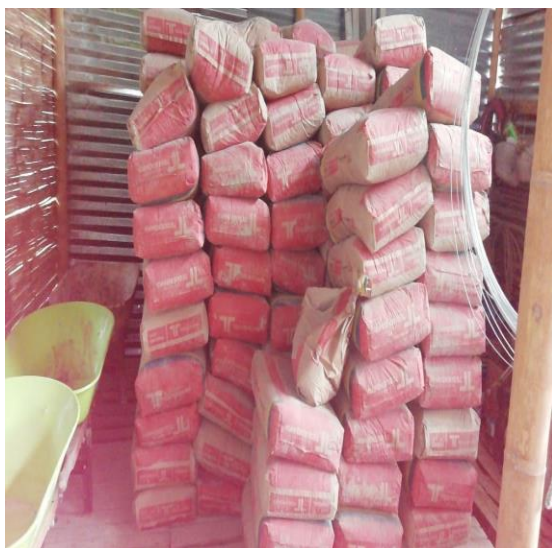
Descargue de cemento
