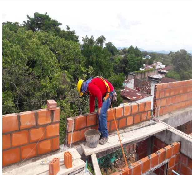
Instalación alambrón zona closet torre B
