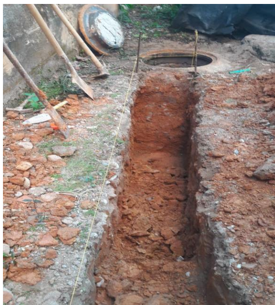
Excavación manual
