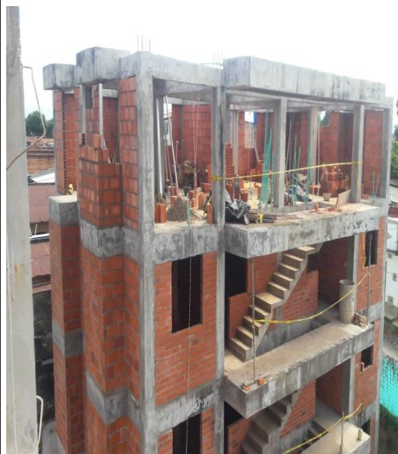
Mampostería torre A
