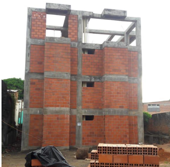
Mampostería torre A
