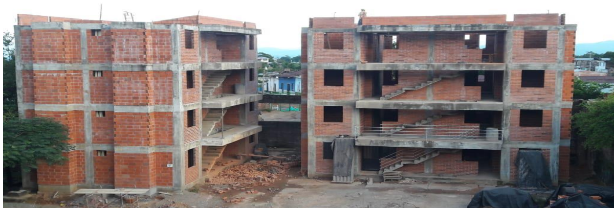
Construcción cuchillas torre E y F
