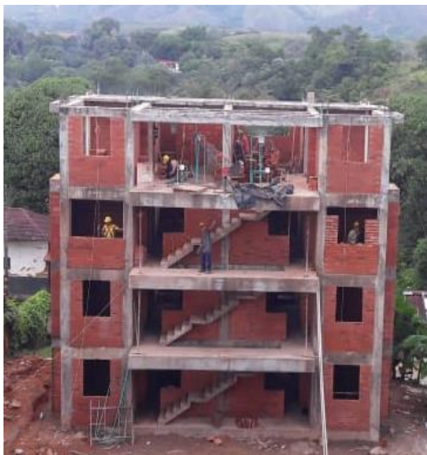
Mampostería torre B
