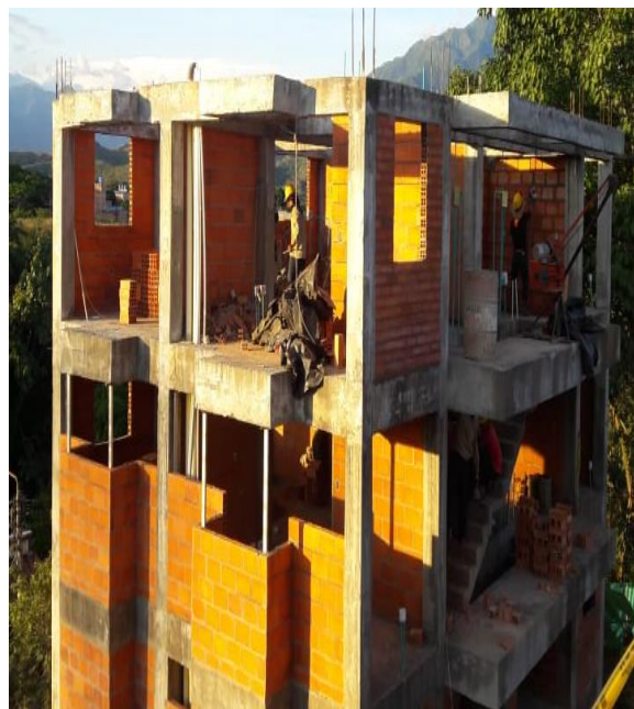
Mampostería torre B piso 3 y 4
