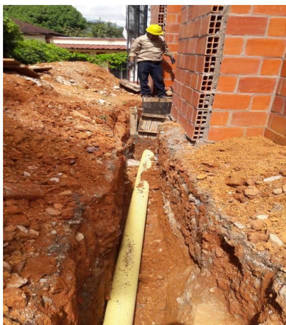
Instalación tubería
