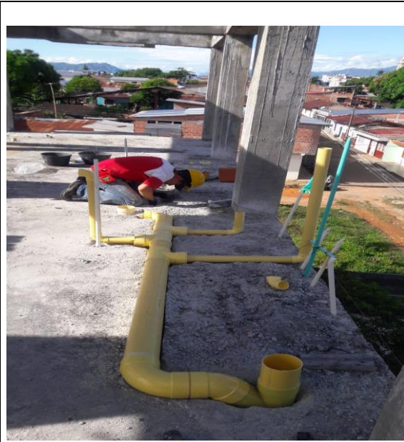
Cambio de tubería
