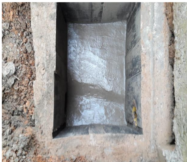
Fundición de caja de inspección
