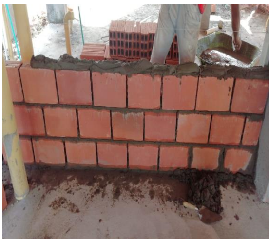
Inicio pega de bloque torre A
